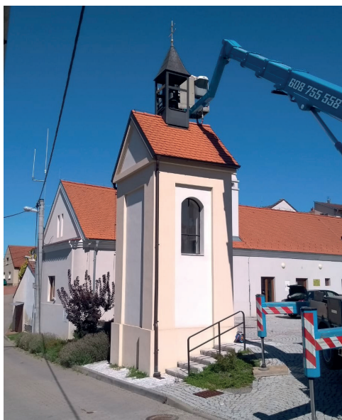
zavěšování nového zvonu na kapličku
